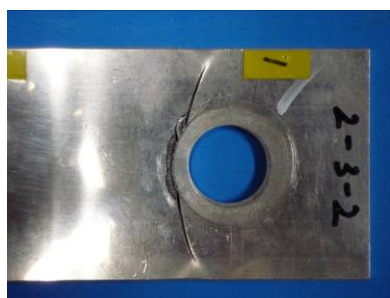
図 1.5 座金と接触する添接板の表面に発生した疲労亀裂
