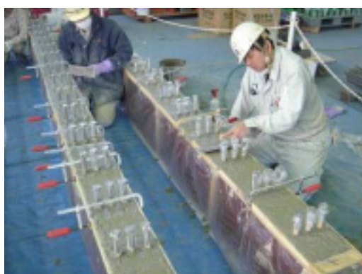
図-A.5 ECC の表面仕上げ状況
