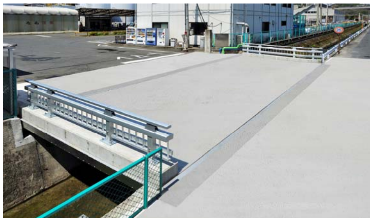
写真3 完成した蒲原ケミカル橋
