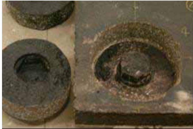
図 - 5 ボルト周りの充填状況
