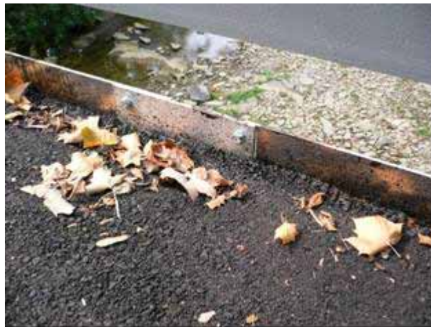
図 - 10 アルミニウム側板の接合
