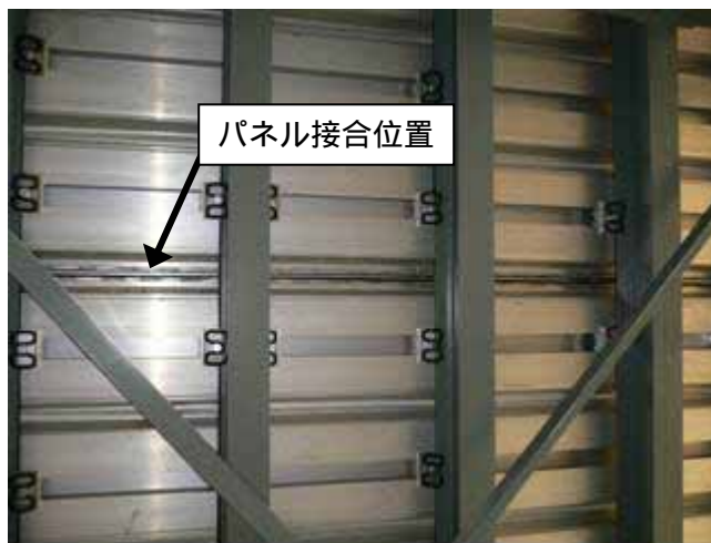
図 - 6 橋の下から見上げたパネル間接合の様子
