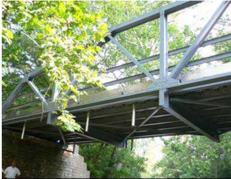
図 - 2 アルミニウム床版が施工されたトラス橋
